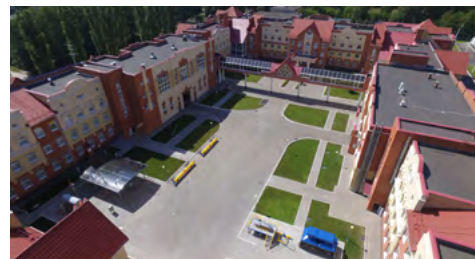
Учебно-производственный центр «Газпром трансгаз Москва» в Тамбовской области
