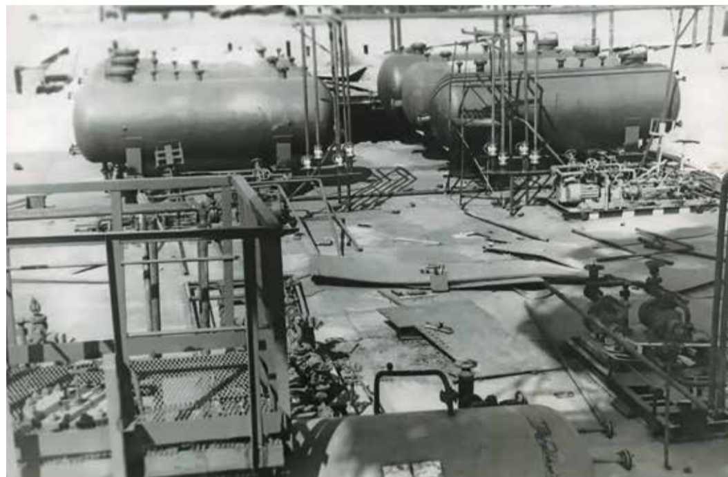
Строительство установки получения дизельного топлива, 1984 г.
