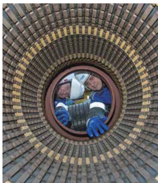
Выполняется осмотр статора высоковольтного электродвигателя
