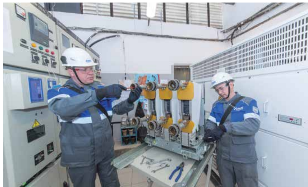
Электромонтеры Виталий Качурин и Виталий Иванов ведут ремонт высоковольтного вакуумного выключателя
