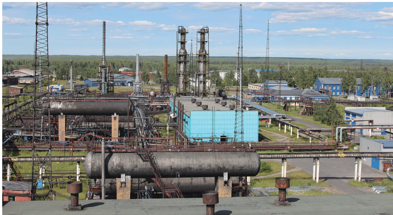
Цех № 1. Вид сверху. Установка стабилизации конденсата № 1
