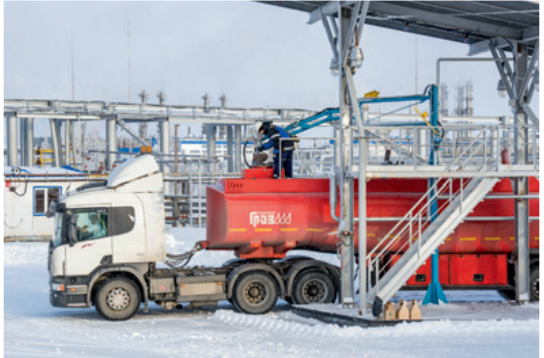
Наливная эстакада ЗПКТ. Отгрузка топлива для реактивных двигателей марки ТС-1
