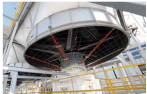
Аппараты воздушного охлаждения установки получения пропан-бутана
