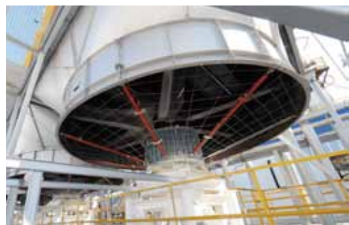
Аппараты воздушного охлаждения установки получения пропан-бутана
