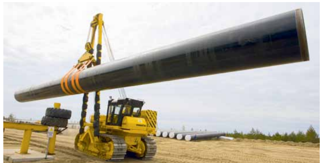
Трубы большого диаметра должны обеспечить надежную транспортировку газа
