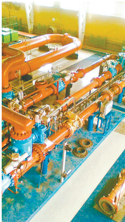
Система измерений количества газового конденсата УЗ № 2
