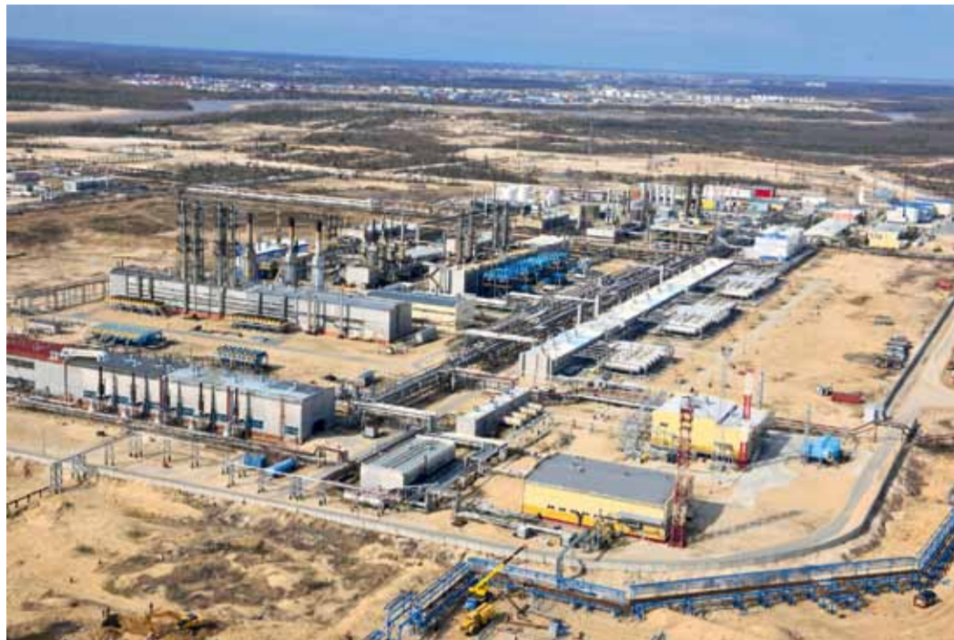
Завод по подготовке конденсата к транспорту
