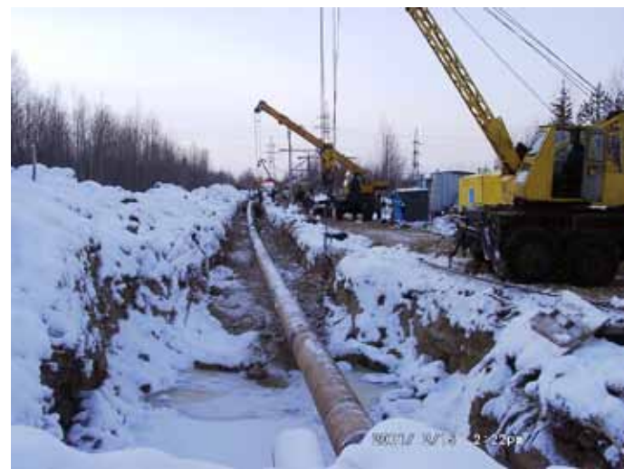
Ремонт газопровода в зимний период
